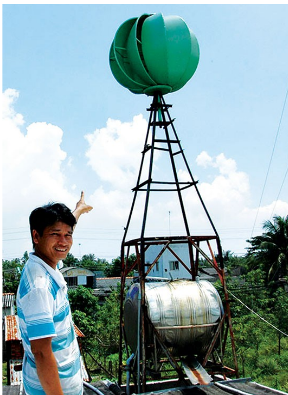
Máy phát điện bằng sức gió được đặt trên nóc nhà - Ảnh.NVCC.
